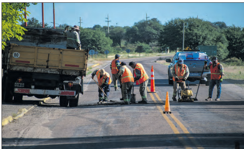
Personal de Vialidad comenzaron trabajos en la Ruta N° 75.
