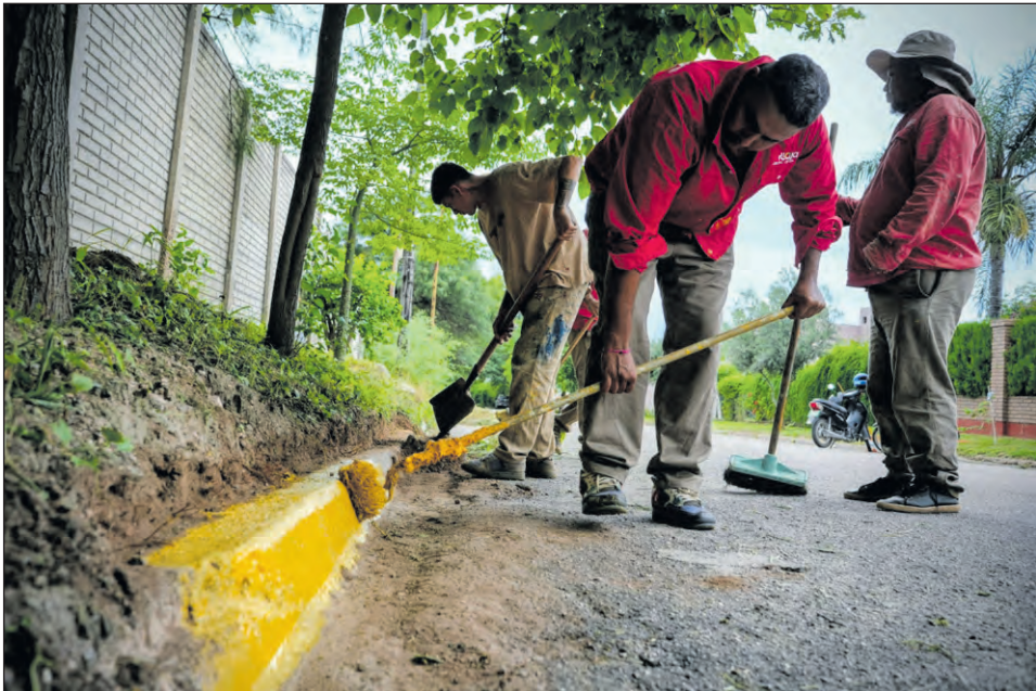
Operarios de la Municipalidad en plena tarea de mejoras en el pasaje San Anotnio.
