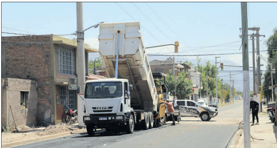
Operarios en plena tarea de pavimentación de la calle “Chacho Peñaloza” de esta capital.
