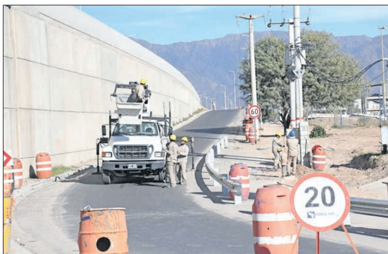
Operarios de Edelar ejecutando las tareas en torno al derivador vial del Chacho.
