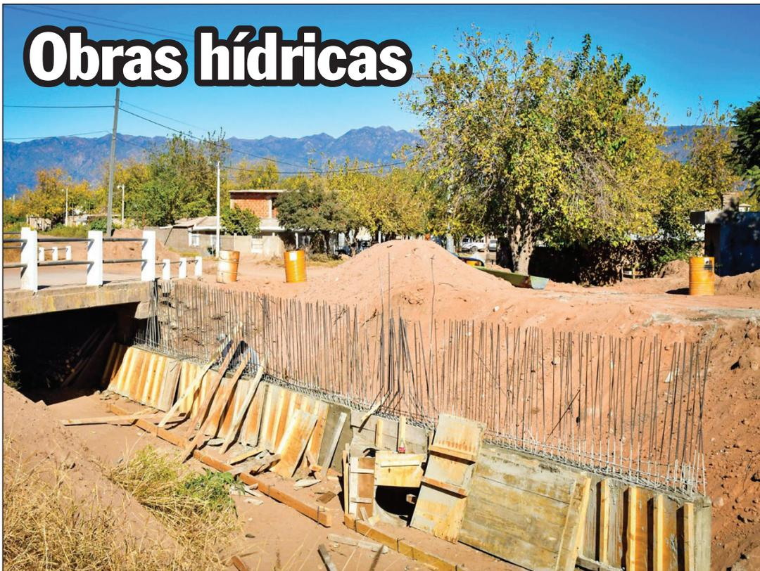
La Provincia trabaja en inmediaciones del puente principal de la ciudad de Chemical, la obra que permitirá encauzar el agua de lluvias y prevenir a los habitantes ante un eventual temporal. El proyecto contempla la instalación de una cañería de desagüe pluvial para canalizar el agua durante las lluvias hacia el cauce del río Tirante y reducir el riesgo de anegamientos.
