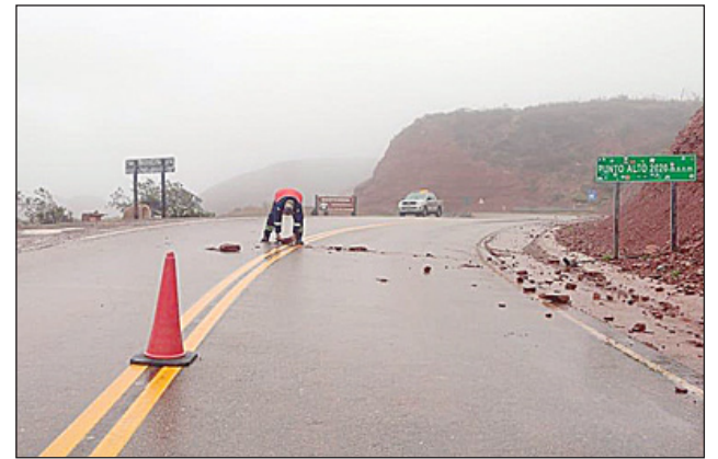
Hubo desprendimientos de roca en varias rutas del ámbito de esta provincia.
