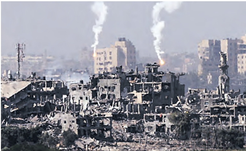
Gran parte del enclave palestino quedó reducido a escombros y cenizas.
